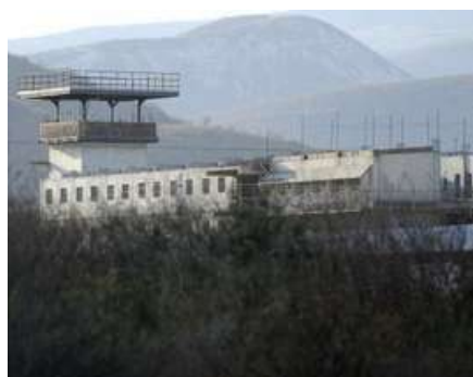
Cárcel de Fenix en construcción Foto Cortesía: BBC
